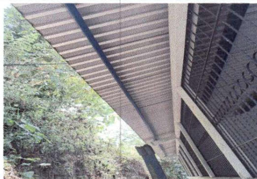
FOTO 4 Sustitución de canal de metal
