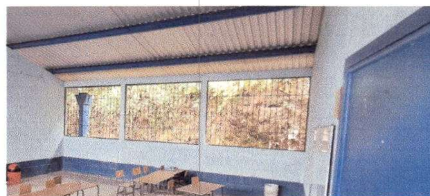
FOTO 2 Mantenimiento a estructura de metal de ventana
