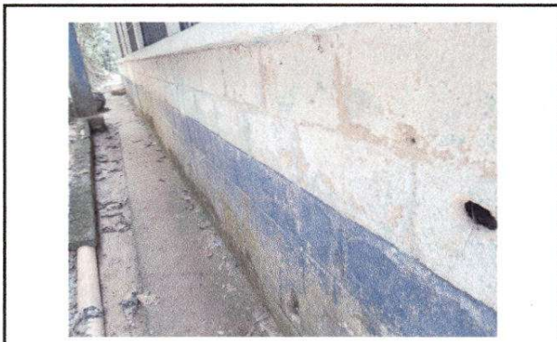
FOTO 7 Repello en muro, cernido
