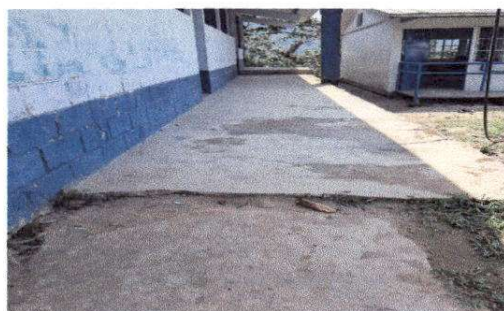
FOTO 5 Reparación de banqueta de concreto
