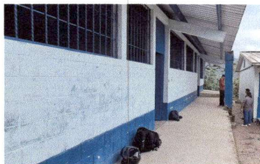
FOTO 6 Pintura en muros exteriores e interiores
