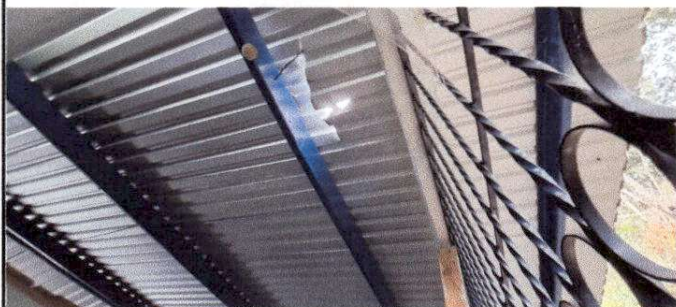
FOTO 1 Sustitución de lámina troquelada aluzinc cal.26
